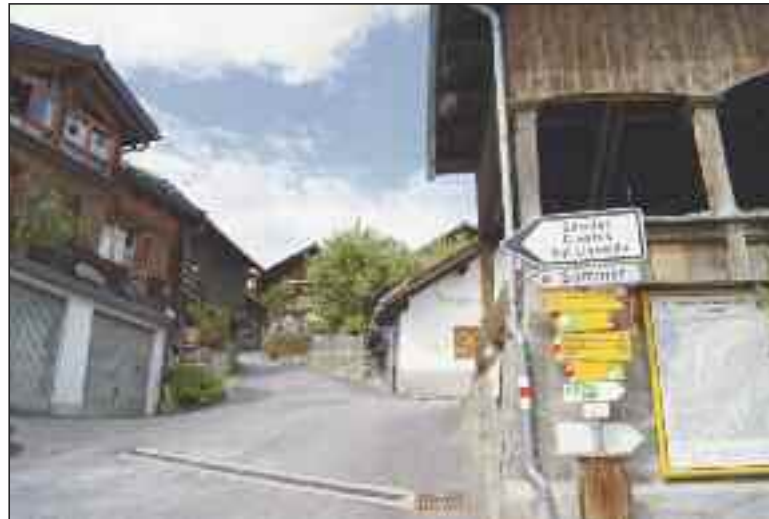
Mit Rütis Hilfe saniert: die Via Cava Bletscha rechts neben dem Dorfbrunnen.
