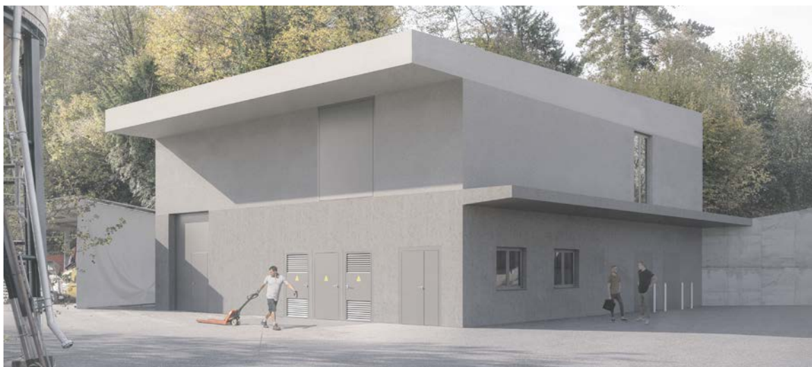
Auf dem Dach der im Bau befindlichen Wärmezentrale plant Solarify eine Solaranlage.
