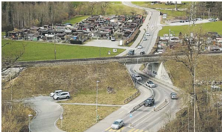
Die Holzwiesstrasse von Jona Richtung Rütli aus gesehen. Der Sanierungsabschnitt verläuft von der SBB-Unterführung (Bildmitte) Richtung Joner Zentrum (unterer Bildrand).
