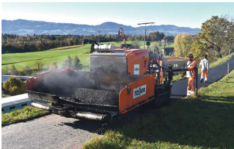
Asphaltierung des Fusswegs im Chlaus.
