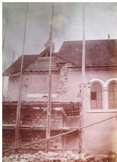
Abriß bis zum Fundament des zu bauenden Turmes.
