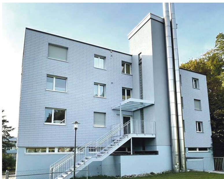
Kindergarten in einer Liegenschaft der Wohnbaugenossenschaft Weier.
