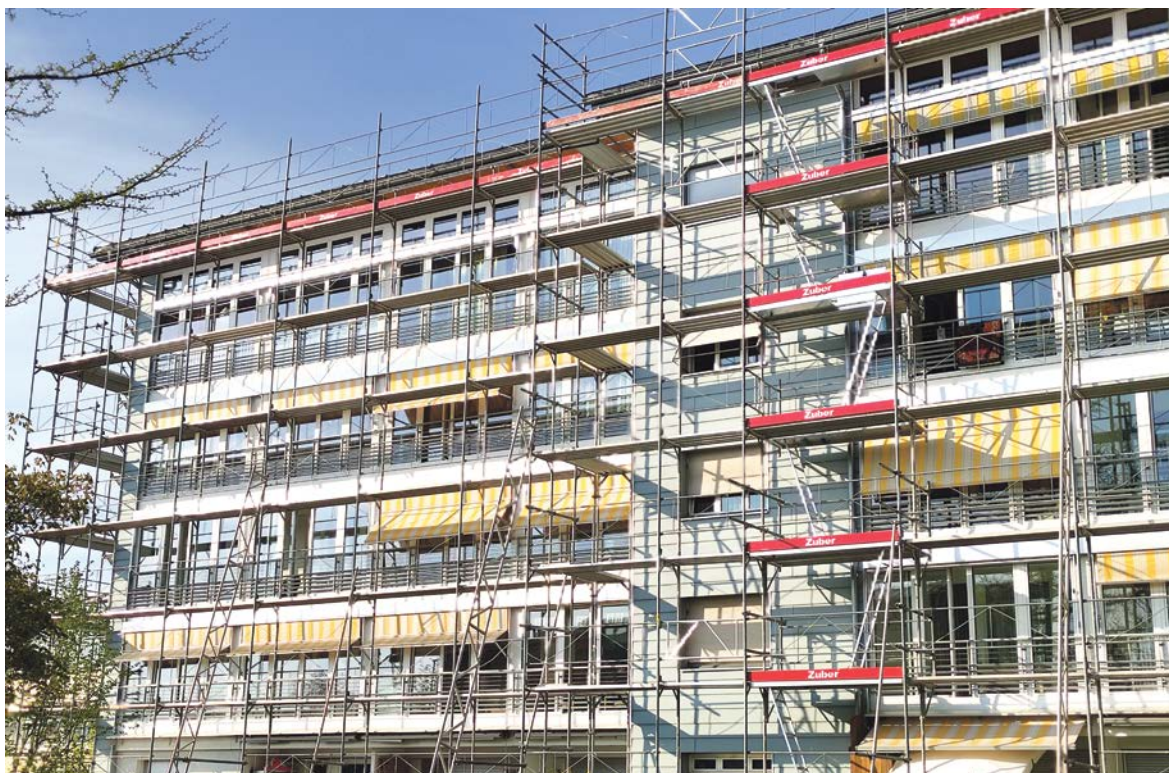
Haus 1 im Gerüstkleid.
