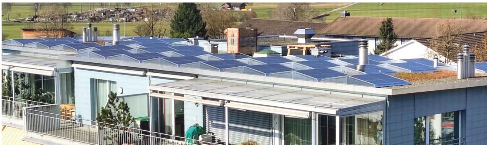
Interessante Aussicht aufs und vom Dach.
