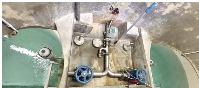
Fassung der Spitalquellen.
