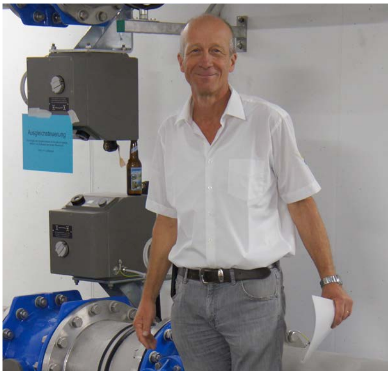
Thomas Leutenegger im neuen Reservoir Laufenbach.
