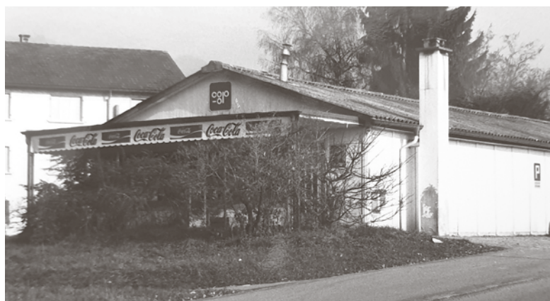
Baracke Würzhalde, Fägswilerstrasse 1.
