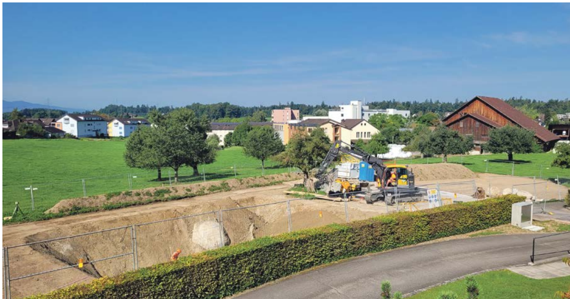
Zwischen Krematorium und Zentrum Breitenhof haben die Aushubarbeiten für den Energy Hub begonnen.
