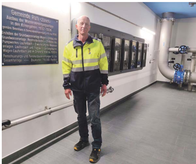
Thomas Leutenegger, Leiter Wasserversorgung Rütli.
