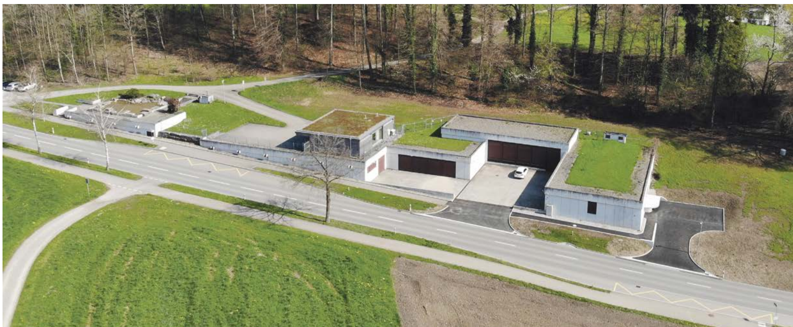
Filteranlage Mühleholzli in Stäfa.
